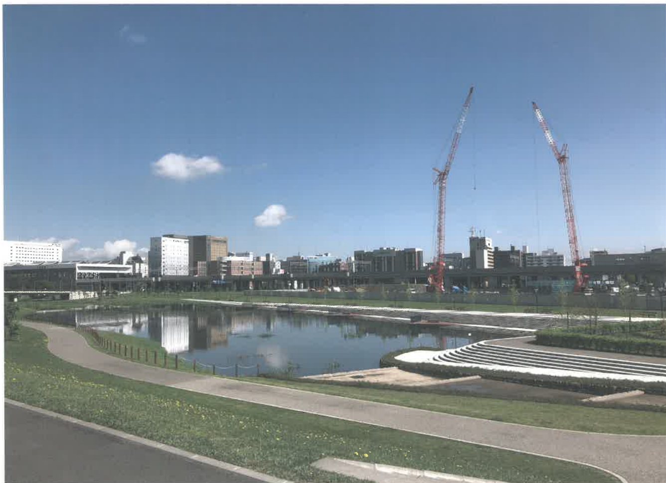
新病院の建設風景
